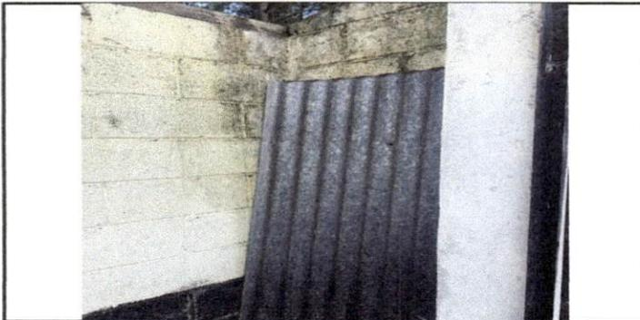
Foto 8: Muros de modulo de baños dañados por humedad.
